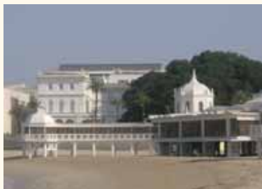
La UCA ha instalado en la Facultad de Económicas y Empresariales la mayor planta fotovoltaica urbana construida en España.
