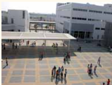
Durante el curso académico 2007-2008 comenzaron las obras de las nuevas instalaciones deportivas del Campus de Jerez.
