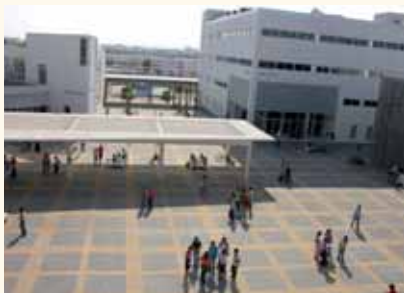
La UCA ha comenzado las obras del nuevo Centro de Formación Ocupacional en el Campus de Jerez, que albergará aulas adecuadas al EEES.
